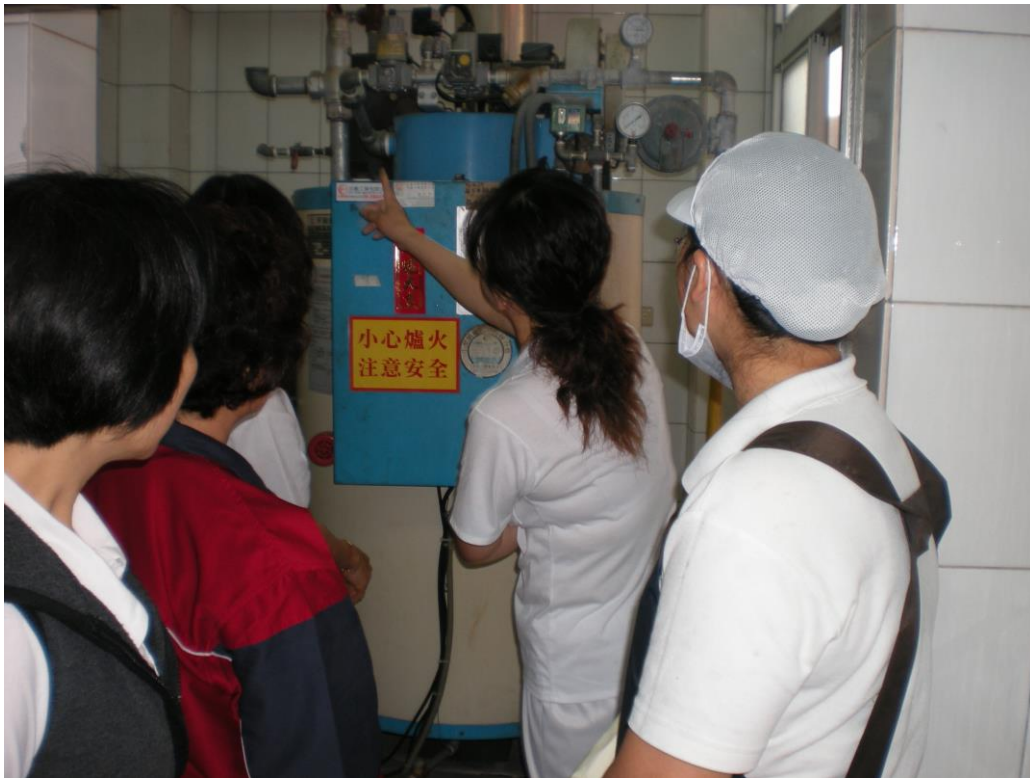
每日作業前後設備檢查
